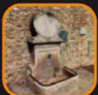
4_ Font de Gràcia o de la Cantereria / Fuente de Gracia o de la Cantereria / The Gracia or the Cantereria Fountain
